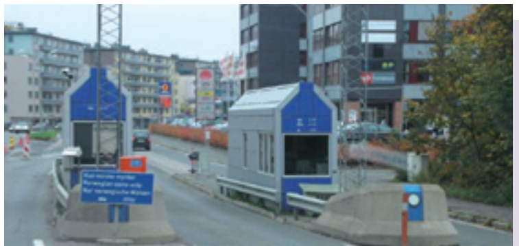
写真3. 一般道における料金所の外観（オスロ市内）
