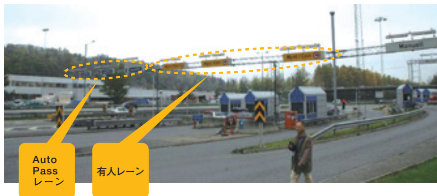
写真 4. 幹線道路における料金所の外観（オスロ市内）
